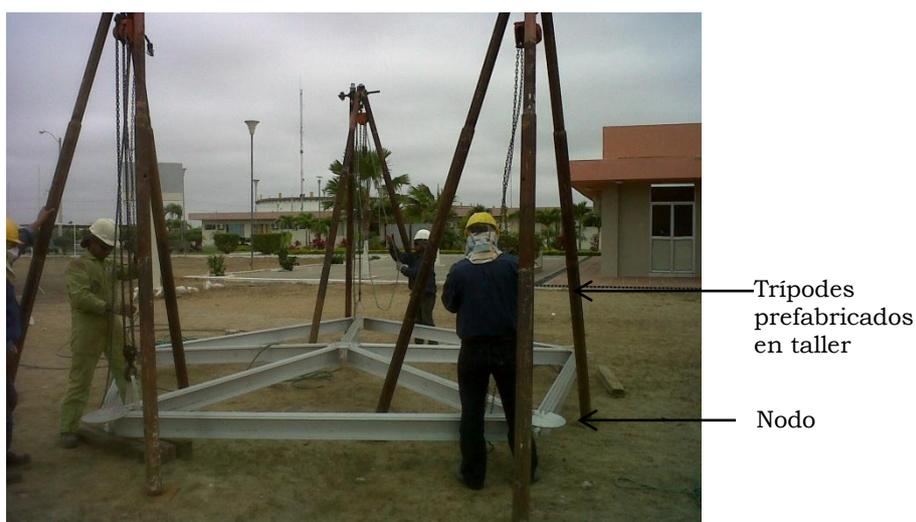
Foto 15. Inicio del armado del Domo.<sup>46</sup>
