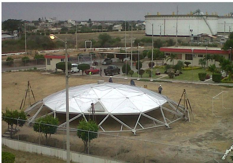
*Foto.17 Instalación de los paneles del Domo.<sup>49</sup>*
