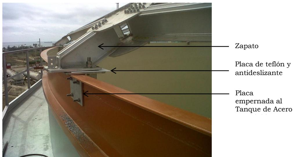
*Foto.19 Instalación de los zapatos de soporte.<sup>51</sup>*
