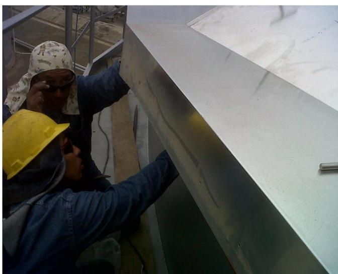
*Foto.20 Instalación de Paneles finales y Faldón<sup>52</sup>*
