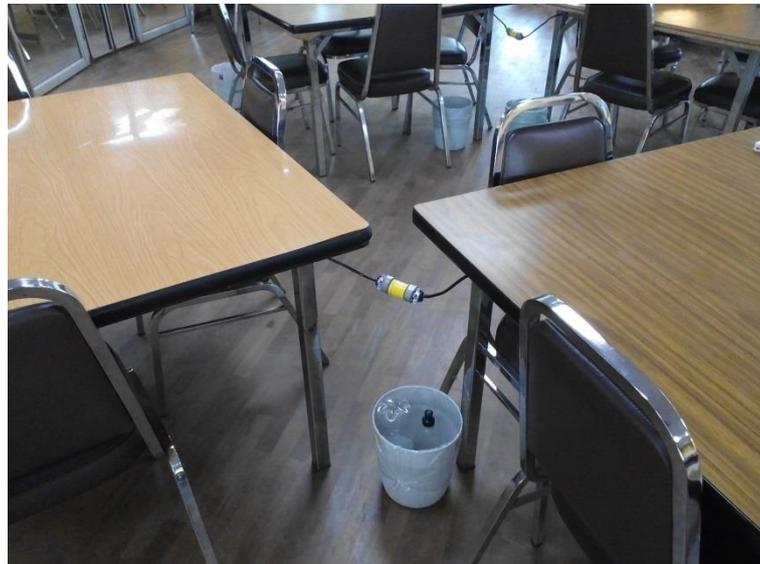
**Figura 3.10. Instalación Insegura (Área de Estudios del CIB Planta Baja – Bloque Antiguo)**
