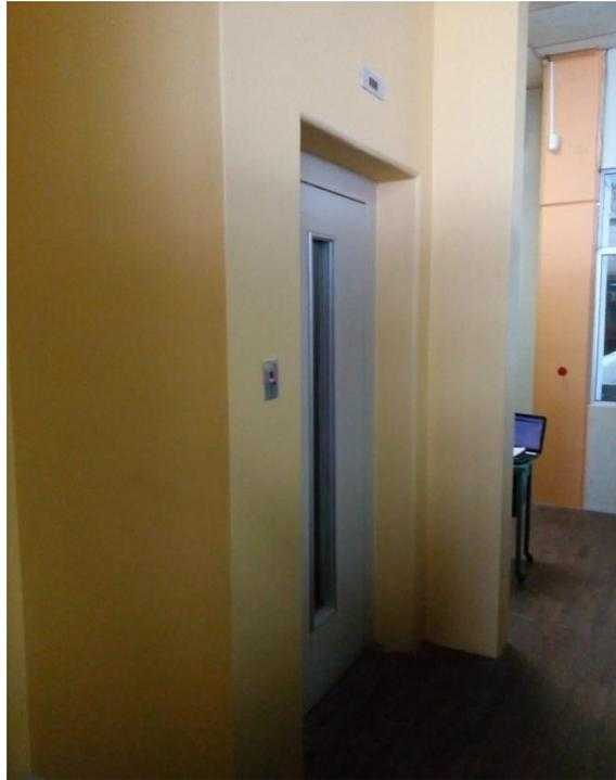
**Figura 3.9. Falta de Señalización (Elevador sin señalización de Utilización en Caso de Emergencia)**
