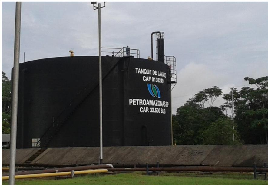
**FIGURA 2. 5: Tanque de lavado**
