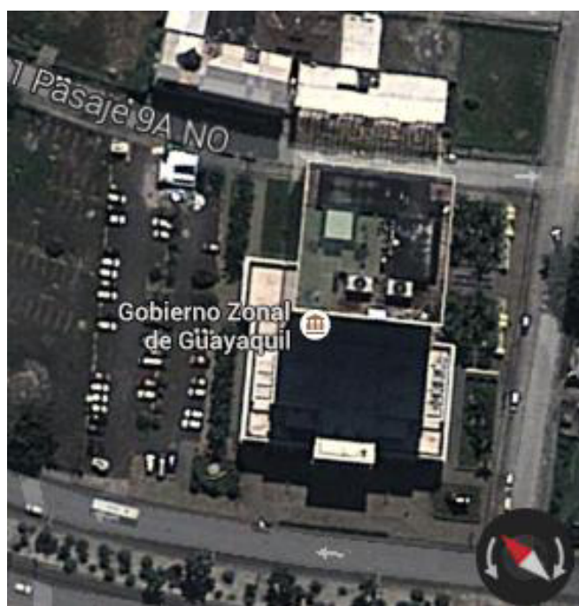
FIGURA 4.1 UBICACIÓN DE EDIFICIO.
