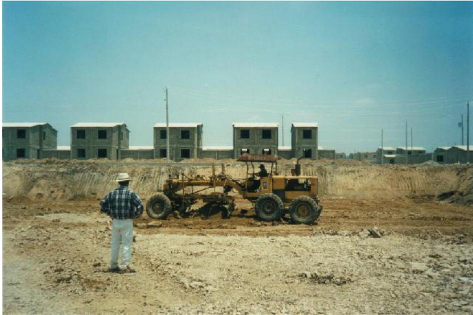
**Anexo 7.3** Observación del descabezado de bancos de material con la motoniveladora
