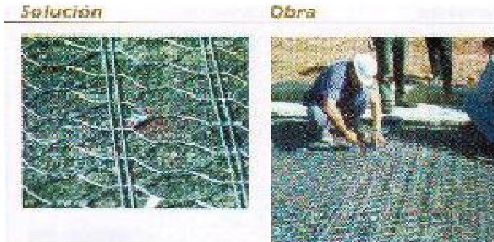
**Figura 6.13** *Solución con mallas metálicas para refuerzo de pavimentos asfálticos*
