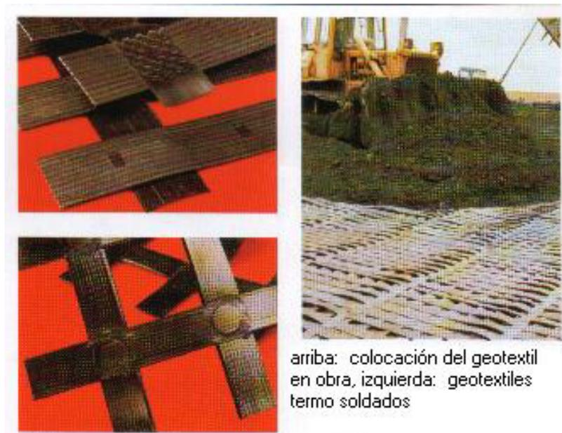
**Figura 6.11** *Solución con geotextil a terraplenes de gran altura sobre suelos blandos.*
