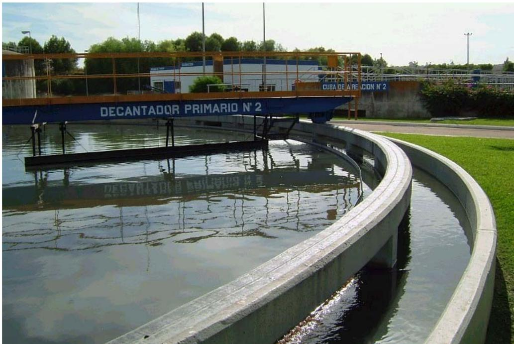
Foto de un Sedimentador típico de aguas residuales.
