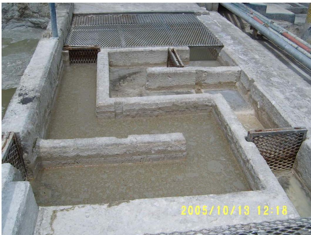
Foto 4. Sedimentador típico planta mirador Holcim.
