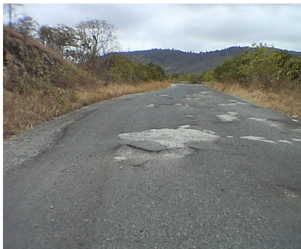
Foto 2.3.2.3. Sección transversal sin bombeo
