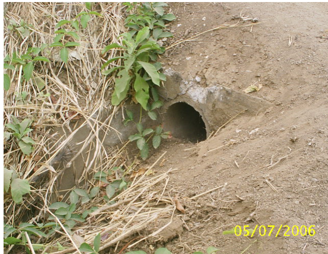
Foto 2.3.9.2. Alcantarilla sección circular existente en la vía
