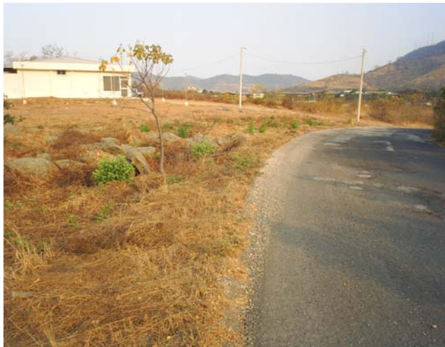
Fotos 2.3.6.15. Espaldones en mal estado
