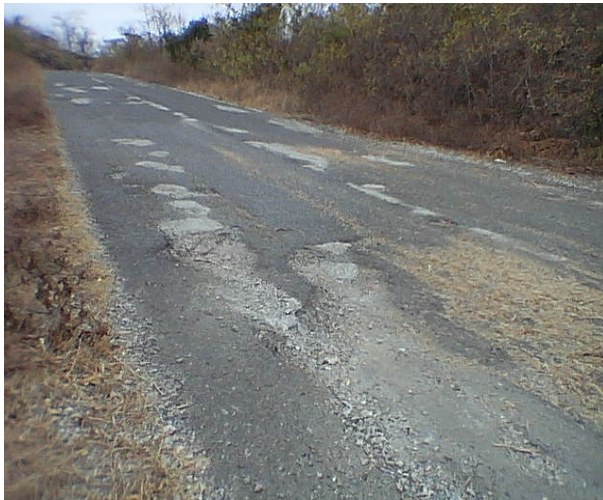
Foto 2.3.6.13. Baches rellenos con hormigón simple
