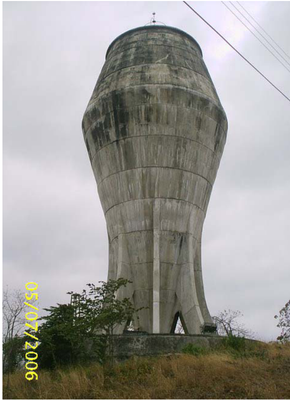
Foto 3.2.1. Reservorio de agua de la ESPOL
