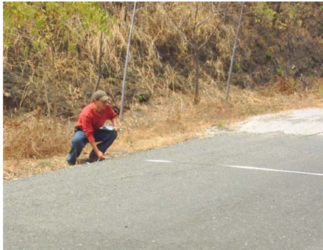
Foto 2.3.6.14. Medición del ancho de la calzada
