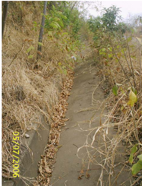
Foto 2.3.9.1. Bordillo – cuneta existente en la vía
