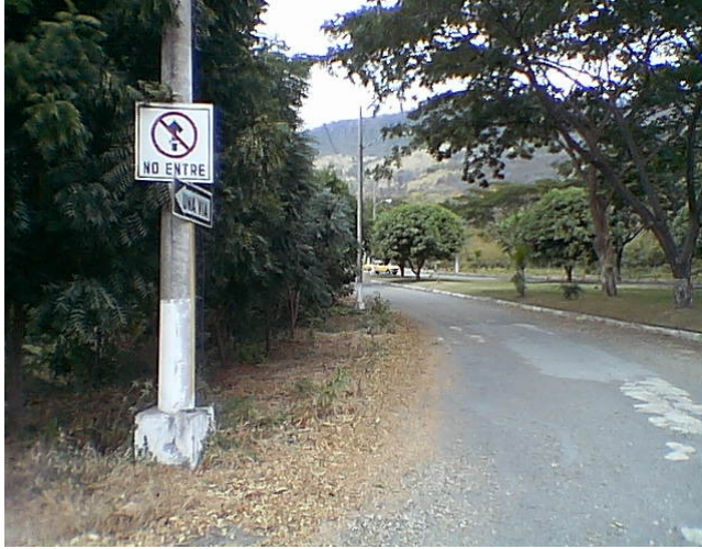
Foto 2.3.8.5. Señal: No Entre / Una Vía Abscisa 0 + 102
