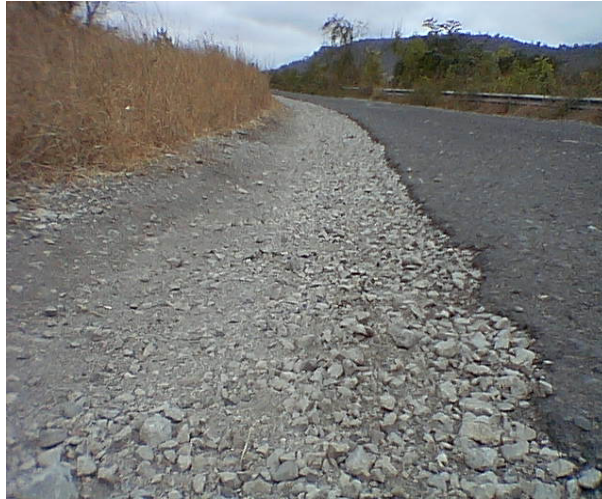
Foto 2.3.6.11. Separación de la película ligante
