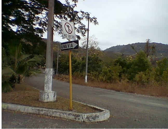
Foto 2.3.8.3. Señal: No Entre / Una Vía Abscisa 0 + 817
