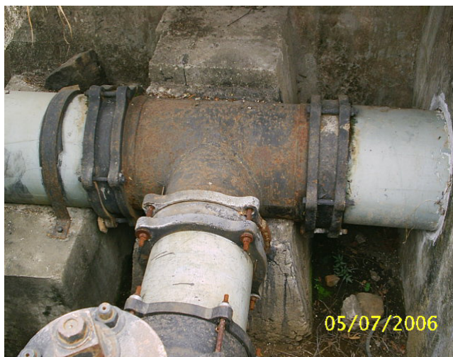
Foto 3.1.1.2. Derivación del flujo por medio de una “T”
