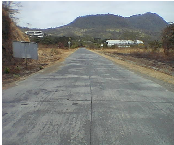
Foto 2.3.1.1. Abscisa 0 + 000 – Fin de tramo de carretera ensayado por la Cemento Nacional
