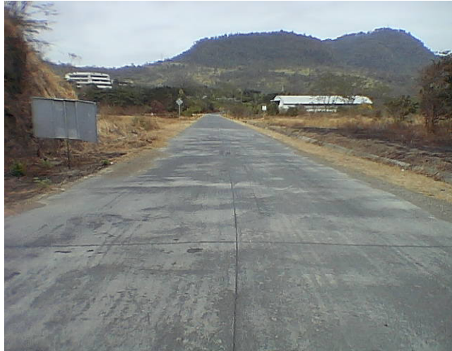
Foto 1.2.1. Tramo de prueba ensayado por La Cemento Nacional – Abscisa 0 + 000
