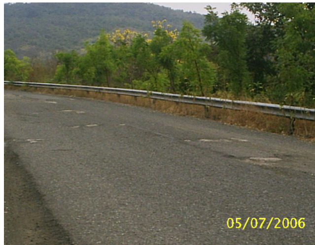
Foto 2.3.7.2. Barandas metálicas existentes en un solo lado de la vía
