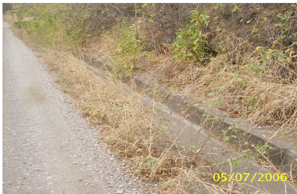
Foto 1.3.12. Obras de drenaje actuales
