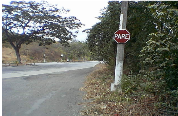
Foto 1.3.10. Señalización Vial existente
