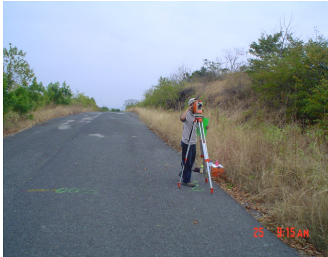
Foto 2.4.1.1. Levantamiento Topográfico con teodolito
