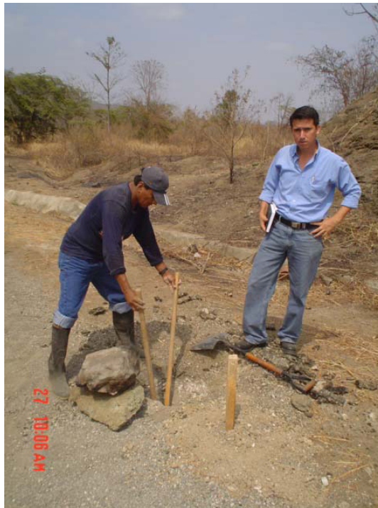
Foto 2.6.1.1. Perforación de las calicatas
