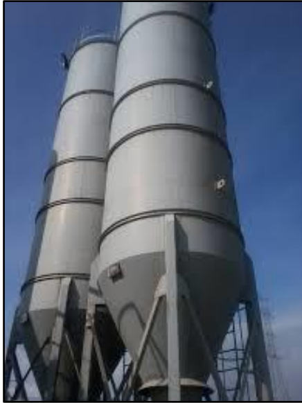
Figura 2.13 Silo de Cemento.
