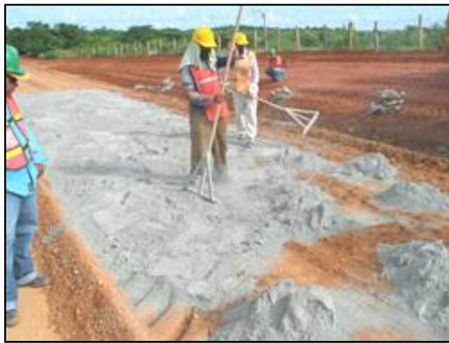
Figura 1.3. Estabilización de suelos utilizando agregados.
