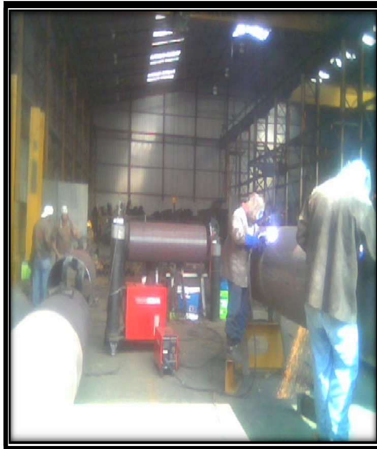
FIGURA 2.13 OBREROS REALIZANDO EL PROCESO DE SOLDADURA CIRCUNFERENCIAL PARA LA UNIÓN DE TRAMOS PEQUEÑOS Y HACER SEGMENTOS LARGOS
