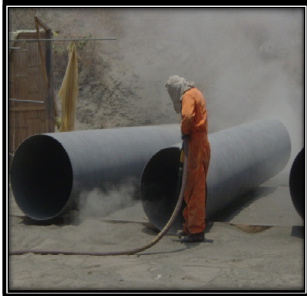
FIGURA 2.14 SISTEMA DE ARENADO POR CHORRO DE ARENA A PRESIÓN DE AIRE (SANDBLASTING) LADO EXTERNO
