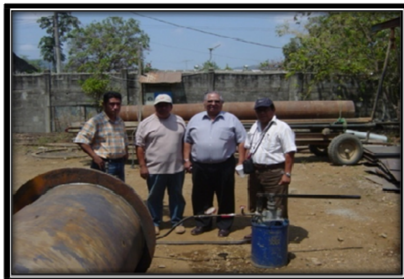
FIGURA 3.2 EN LA PRESENTE FOTO SE APRECIA LA PRESENCIA DURANTE LA PRUEBA AL FISCALIZADOR DE LA OBRA ING. CARLOS ALVARADO, AL ING. I. WIESNER Y AL AUTOR DEL INFORME
