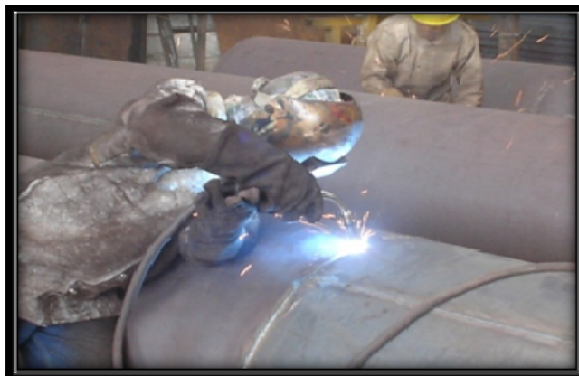
FIGURA 1.6 COMPOSICIÓN GRAFICA DE LOS PRINCIPALES PASOS PARA LA CONSTRUCCIÓN DEL SEGMENTO DEL TUBO
