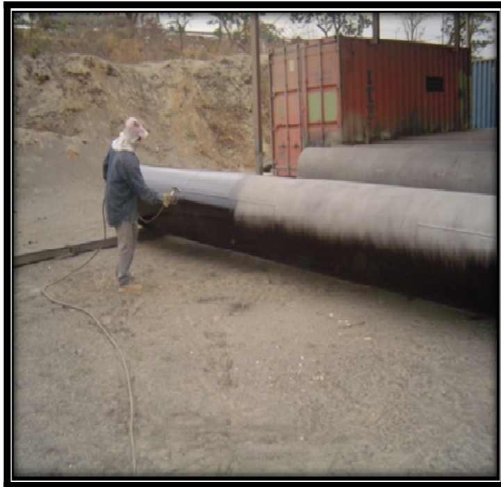
FIGURA 2.16 OBRERO APLICANDO PINTURA POR EL MÉTODO DE PRESIÓN (AIRLESS)
