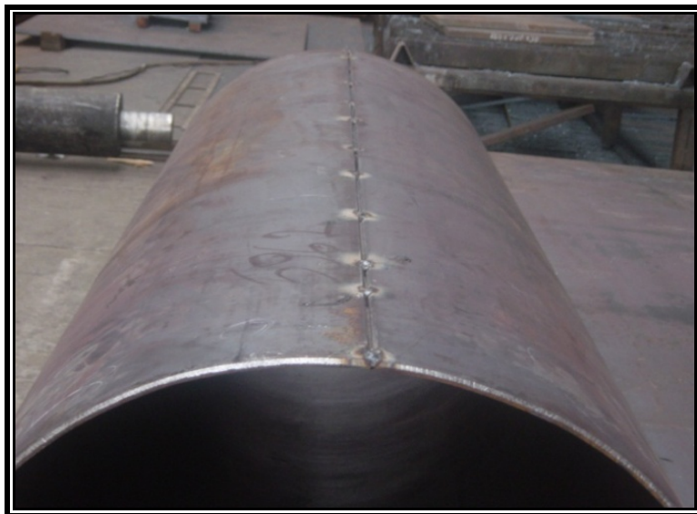
FIGURA 2.10 CHAPA DE ACERO CILINDRADA Y SOLDADA CON PUNTOS
