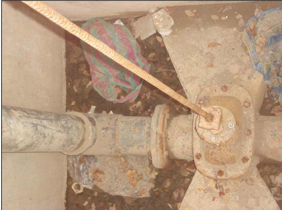
Figura. 3.7 VALVULA DE COMPUERTA DE PASO DE AGUA DESDE EL INGRESO A LA BASE HASTA LA CISTERNA PRINCIPAL
