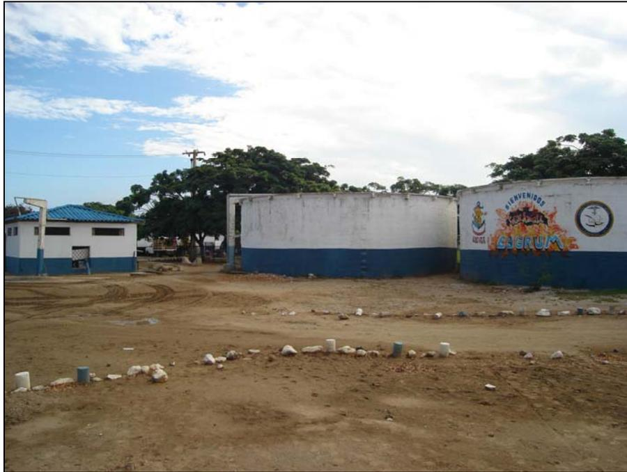
Figura. 3.8 TANQUES DE ALMACENAMIENTO CIRCULARES DE CONCRETO
