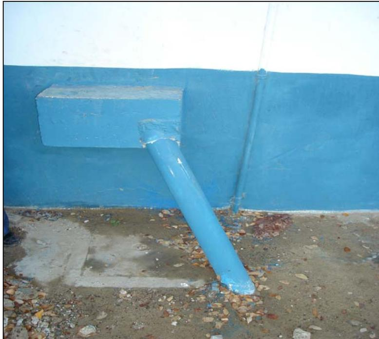
Figura. 3.15 TUBERIA DE 4 PULGADAS DE PVC DE SALIDA DEL CUARTO DE BOMBAS
