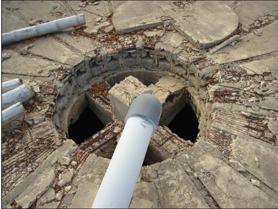
Figura. 3.12 ESTADO DE LAS TAPAS DE INGRESO DE AGUA A LOS TANQUES CIRCULARES DE CONCRETO (VISTA SUPERIOR)
