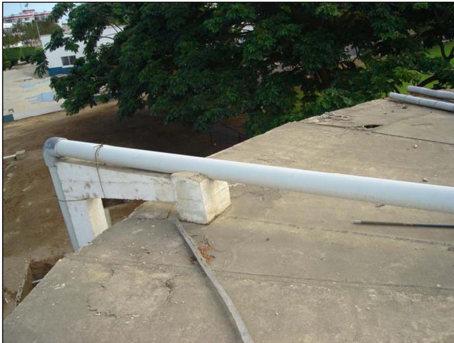
Figura. 3.11 TUBERIA DE PVC DE INGRESO A LOS TANQUES CIRCULARES DE CONCRETO
