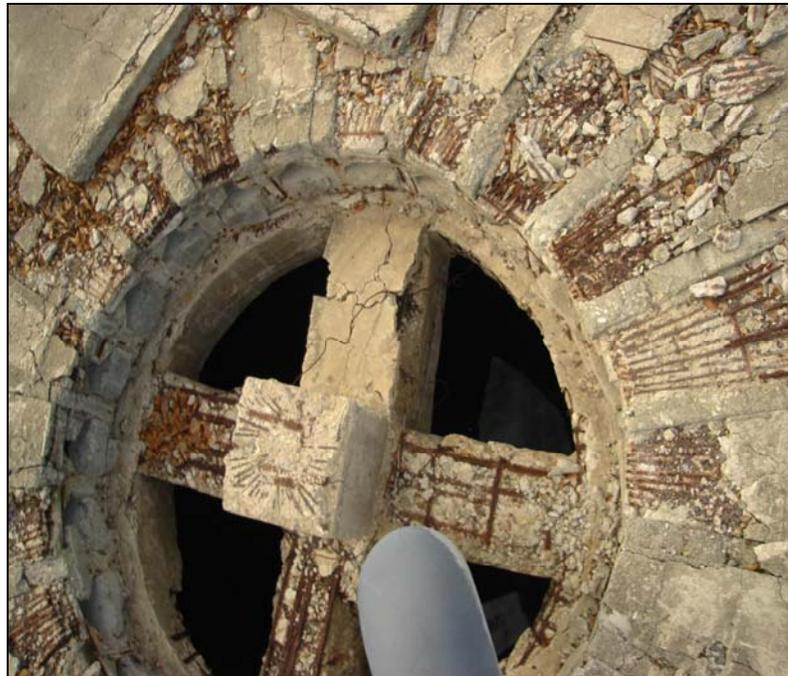
Figura. 3.12 ESTADO DE LAS TAPAS DE INGRESO DE AGUA A LOSTANQUES CIRCULARES DE CONCRETO (VISTA SUPERIOR)
