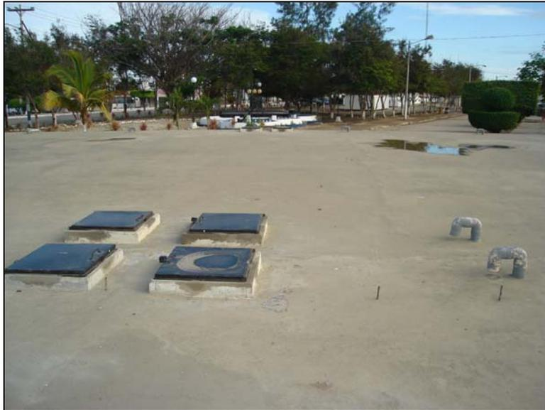
Figura. 3.2 TAPAS DE SECCIONAMIENTO DE AGUA DE LA CISTERNA PRINCIPAL
