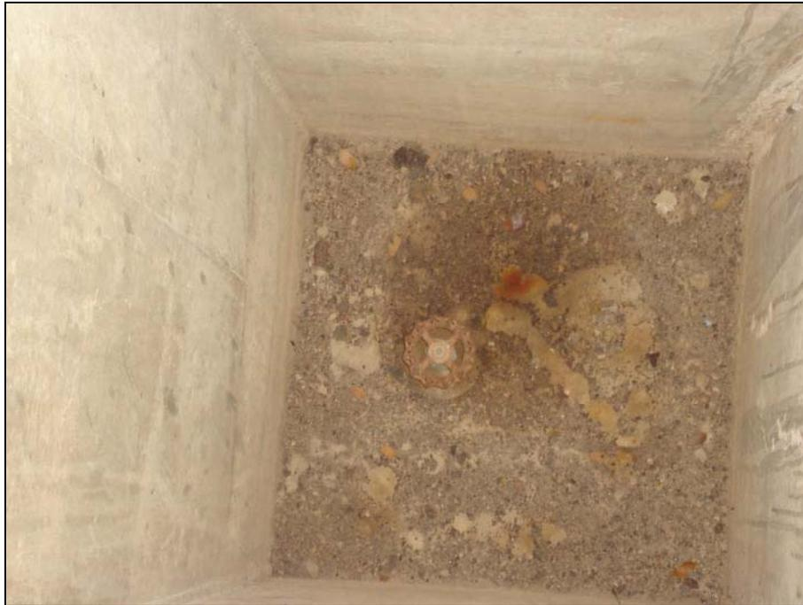
Figura. 3.5 VALVULA DE COMPUERTA PARA SECCIONAMIENTO DE AGUA EN CISTERNA PRINCIPAL
