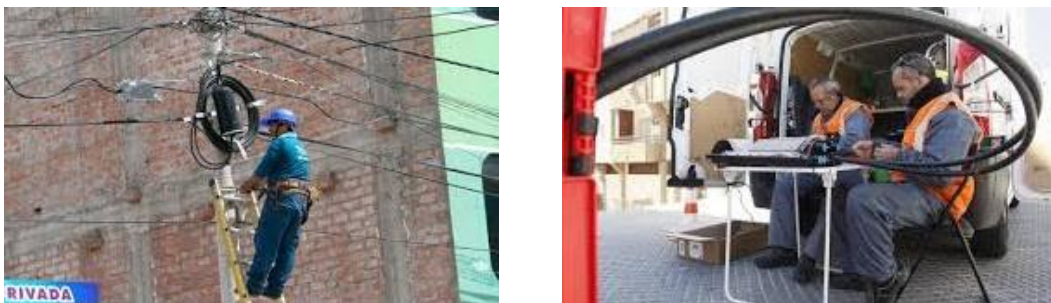
Figura 49. Trabajos de instalación de fibra óptica
