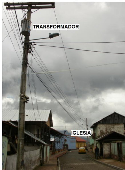
Figura 30. Energía eléctrica para OLT
