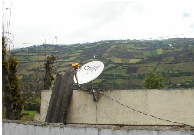
Figura 8. Antena DTH para televisión satelital en Matus
