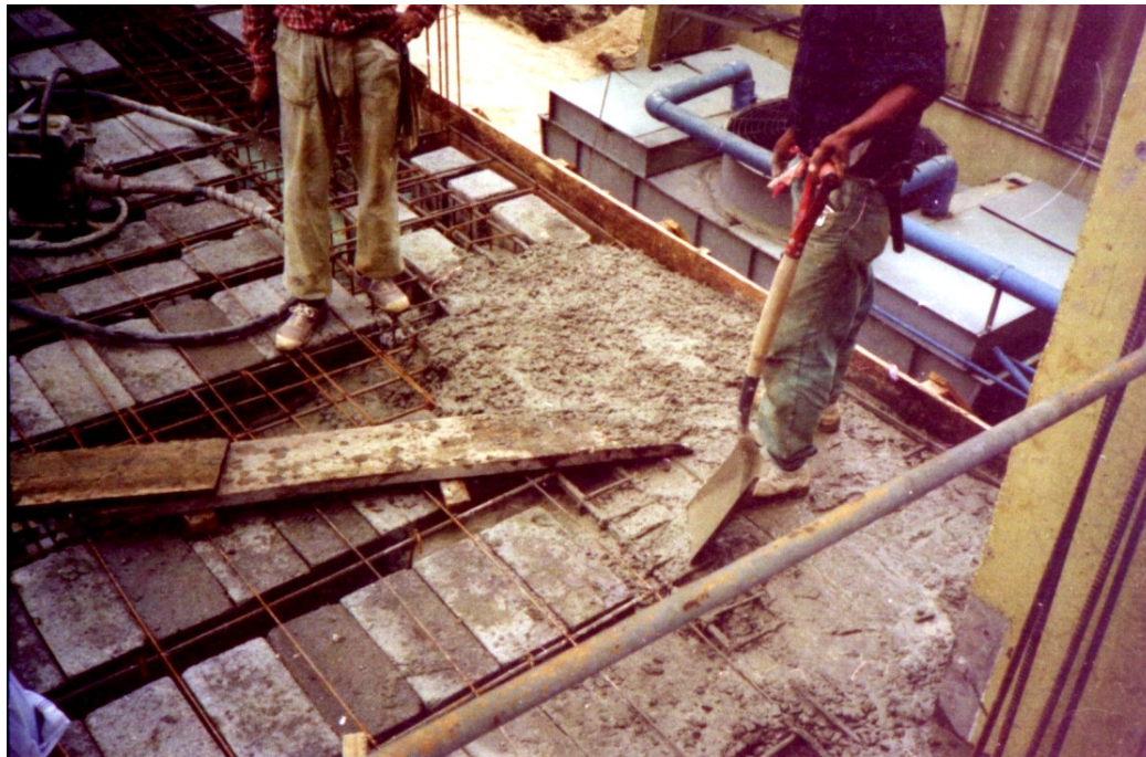
Figura 2.5. Fundición de losa para Condensador Evaporativo
