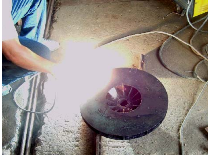
Foto 6: Construcción del impulsor
