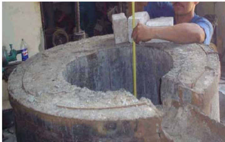
Foto 1: Colocación de los ladrillos refractarios
