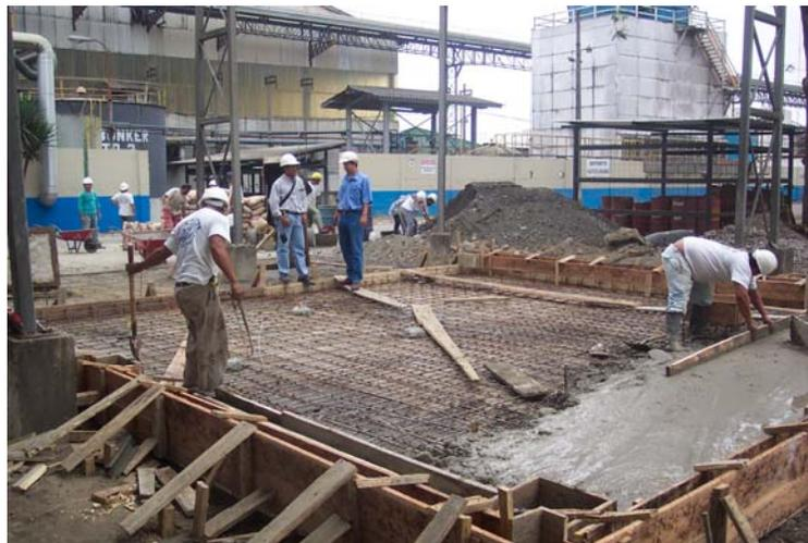
**FIGURA 2.12.** FUNDICION DE LOSA
