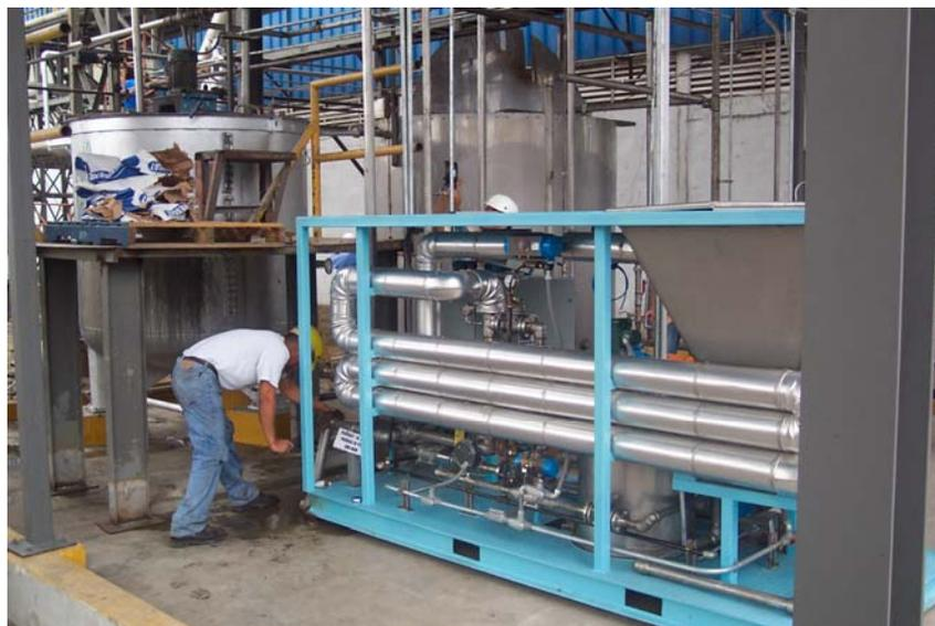
**FIGURA 2.14** MONTAJE DEL JET COOKER
