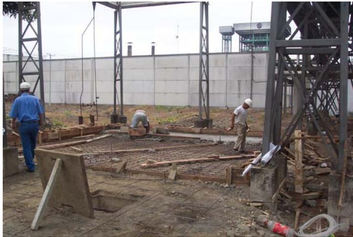
**FIGURA 2.11** PREPARATIVOS DE FUNDICION DE LOSA
