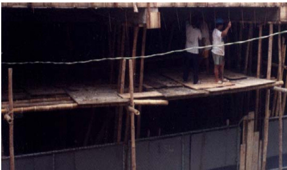
FIGURA 3.6. USO DE CAÑAS PARA LA ELABORACIÓN DE ANDAMIOS
