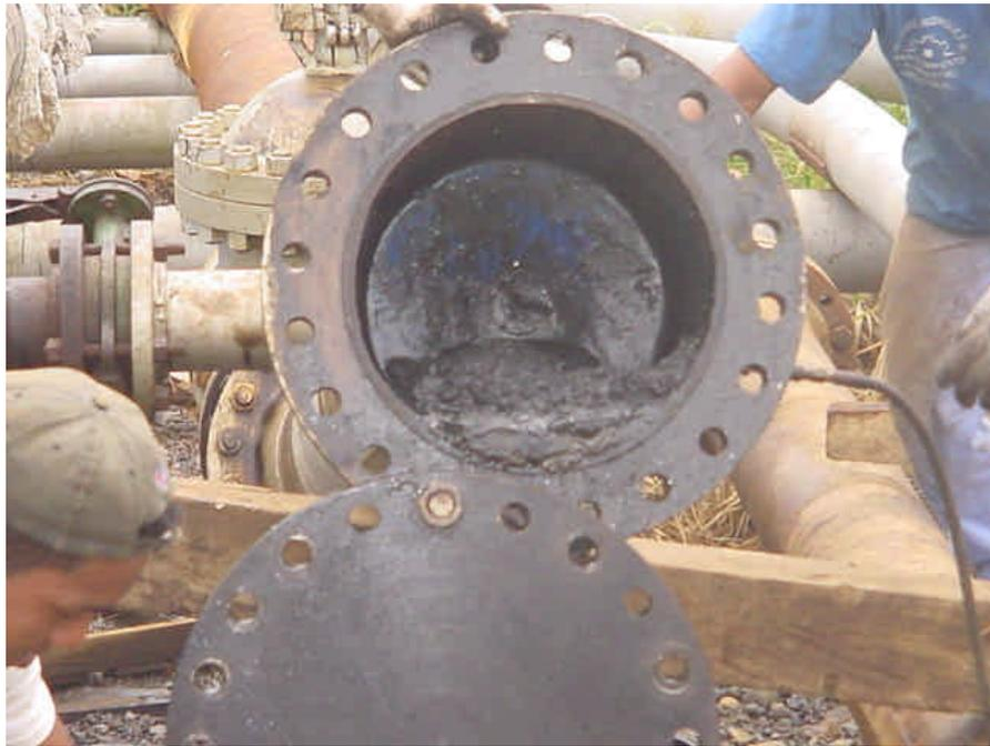
FOTO 7.- DESPLAZAMIENTO DE SEDIMENTOS
