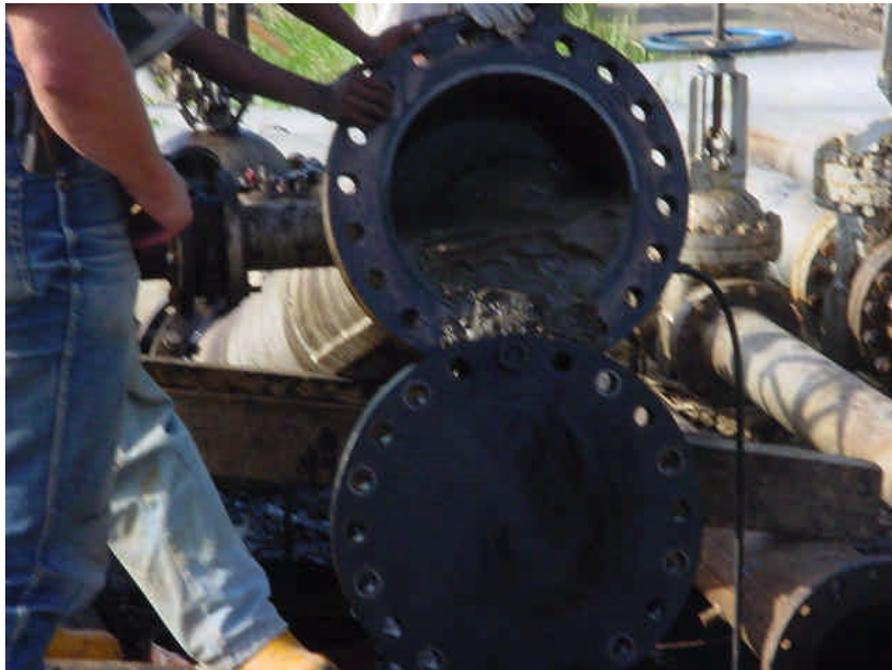
FOTO 8.- DESPLAZAMIENTO DE SEDIMENTOS EN LÍNEA DE 14"
