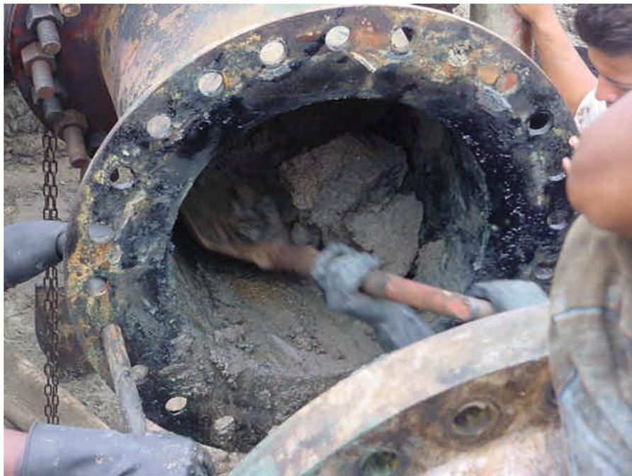
FOTO 14.- DESPLZAMIENTO DE SEDIMENTOS EN LÍNEA DE 20" DE F.O.
