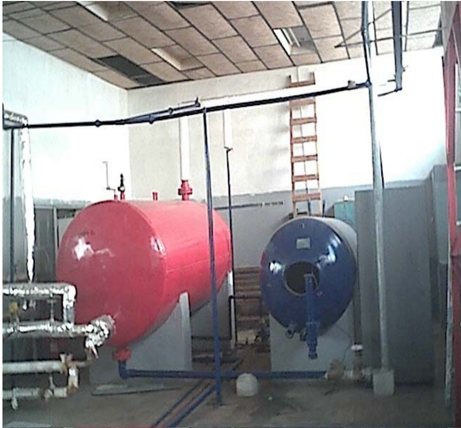
Figura 3.3 : Circuito de ingreso del agua de alimentación 1.
