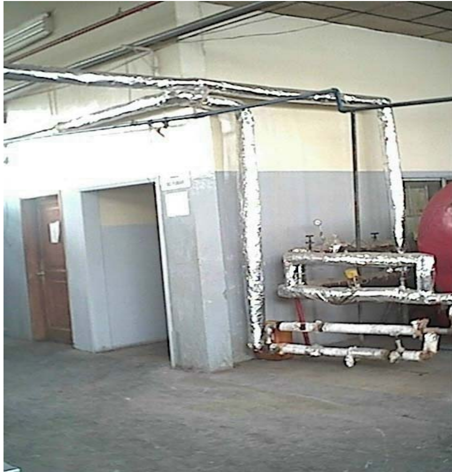
Figura 3.5 : Circuito de ingreso del agua de alimentación 3.
