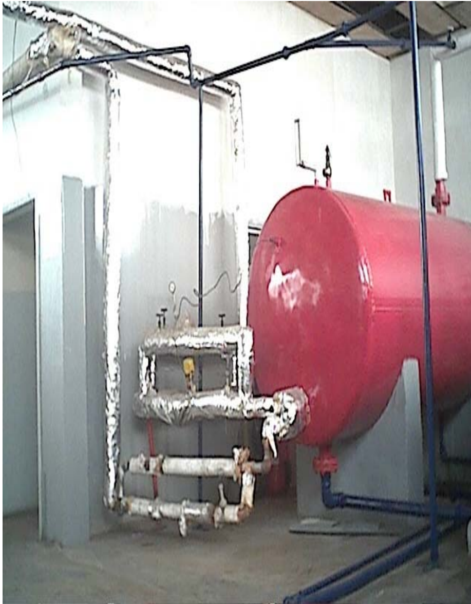
Figura 3.4 : Circuito de ingreso del agua de alimentación 2.
