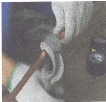
**FIGURA 3.59 UTILIZAR CORTADOR DE TUBO PARA LAS TUBERÍAS**
