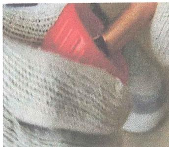
**FIGURA 3.60 UTILIZAR RASPADOR PARA QUITAR LAS REBABAS DE COBRE**
