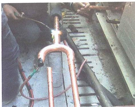
**FIGURA 3.67 PROCESO DE SOLDADURA**
