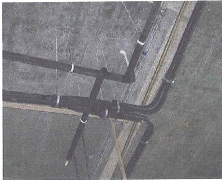
**FIGURA 3.62 CORRECTA INSTALACIÓN DE TUBERÍA DE COBRE**
