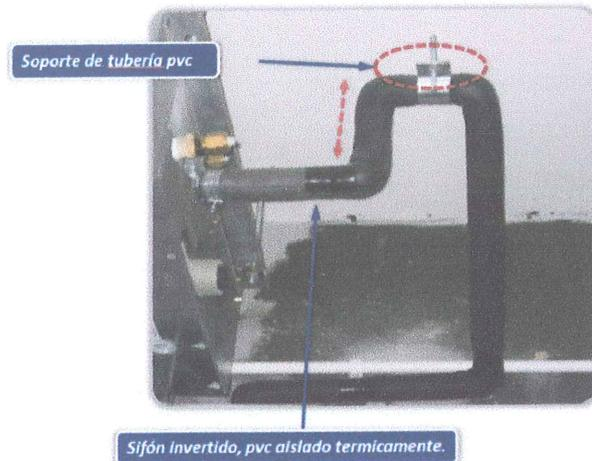
**FIGURA 3.74 DRENAJE DE CONDENSADO**
