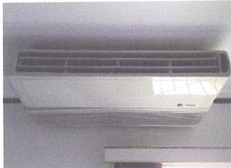
**FIGURA 2.11 UNIDAD EVAPORADOR TIPO PISO TECHO**
