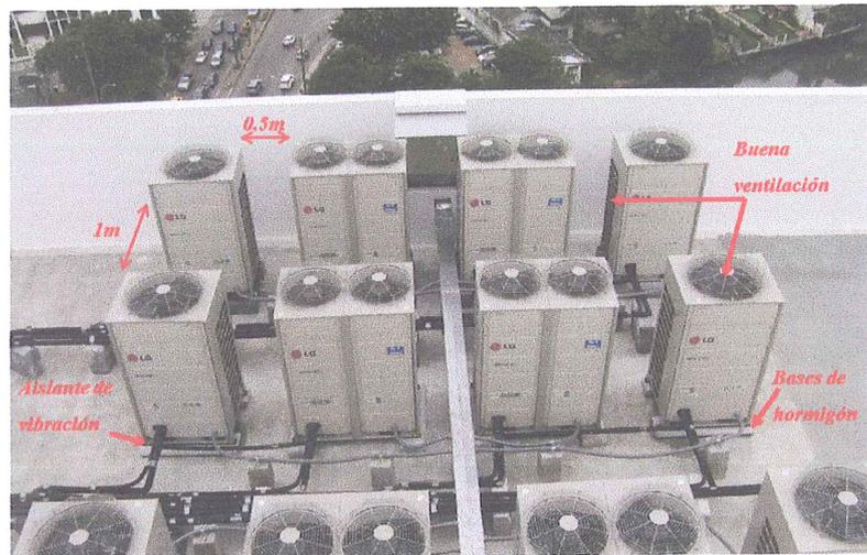
**FIGURA 3.77 CORRECTA INSTALACIÓN DE EQUIPOS CONDENSADORES**
