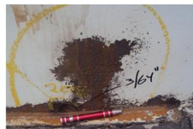
**Figura 3.7 Cordón de soldadura presenta corrosión localizada**
