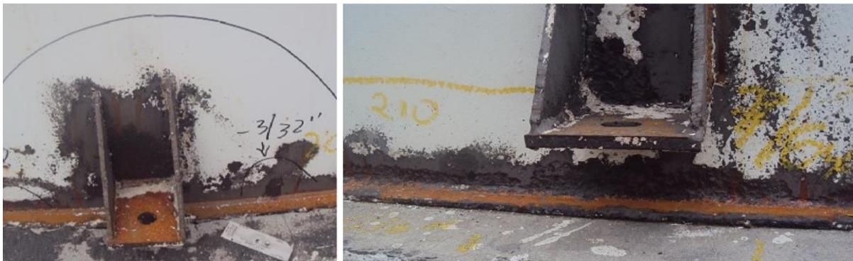
Figura 3.5 Zona de los apoyos presenta excesiva corrosión
