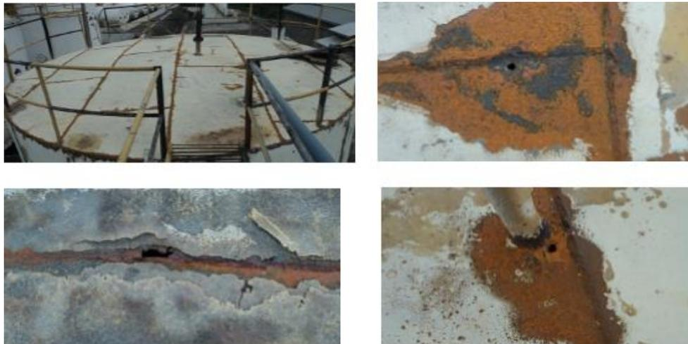
**Figura 2.1 Techo del tanque TS-3, deteriorado, evidencian huecos por corrosión**
