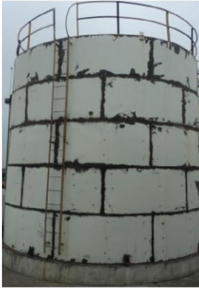
**Figura 3.3 Prueba de hermeticidad en el exterior del tanque.**
