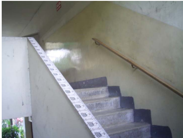
FIGURA 3.1 ESCALERA DEL ASILO
