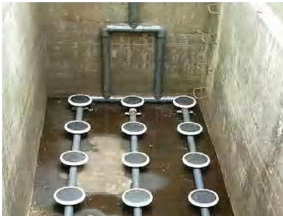
**Figura # 4.3.- Difusores propuestos para la oxigenación del agua en el tanque de aireación, a través del sistema inyector de aire proveniente de la turbina, la cual enviará un flujo de aire de 114.19 m<sup>3</sup>/h**
