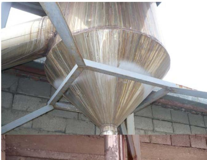
FIGURA 3.7 TORRE DE LAVADO DE GASES
