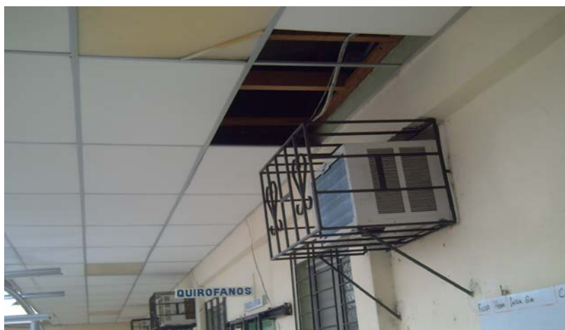
FIGURA 2.2. MOVIMIENTO DEL TUMBADO FALSO EN LA PARTE EXTERIOR DE LA SALA DE CIRUGIA
