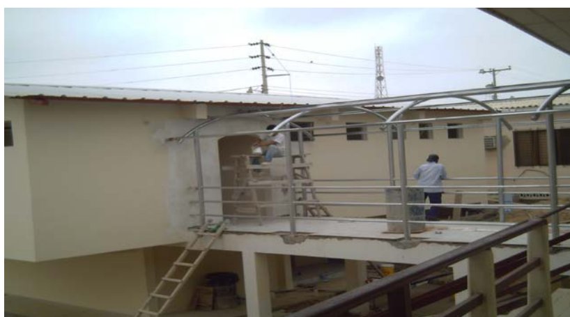
FIGURA 2.1. OBRA CIVIL CERCA DE LA SALA DE CIRUGIA
