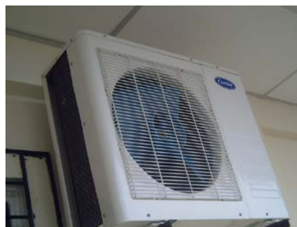
FIGURA 1.6. UNIDAD EVAPORADORA (IZQ.) – UNIDAD CONDENSADORA (DER.) MARCA CARRIER DE 24,000 BTU
