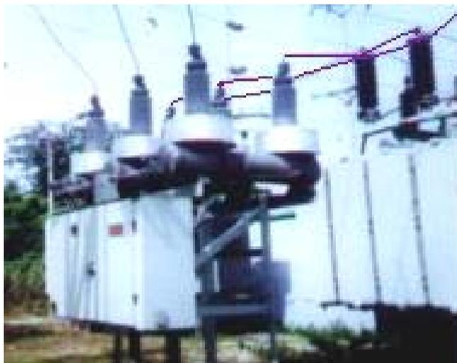
**Figura 3.43:** Barras que van del interruptor SF<sub>6</sub> a los pararrayos del lado de 69 Kv del transformador
