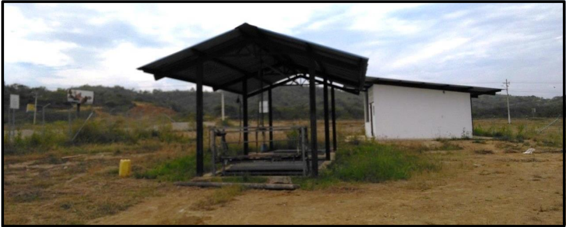
Figura 11.- Estacion de bombeo, comuna de Montañita.
