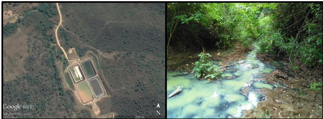
Figura 22.- Descarga de la laguna de oxidacion en el estero Cucaracha.
