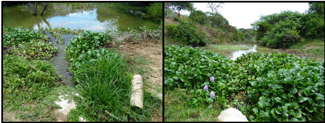
Figura 33.- Tuberías presentes en el vado.
