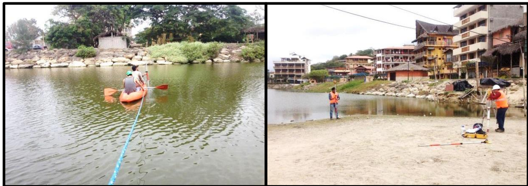
Figura 8.- Levantamiento topografico y batimetrico del estuario Chicharrón.
