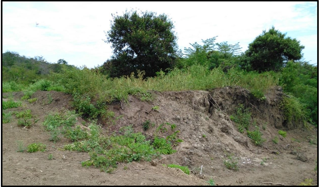
Figura 39.- Rio Chicharron, Zona C. Margenes inestables.
