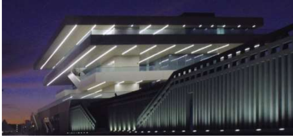
Figura 3.4. Edificio Foredeck en Valencia. Fuente: Arq.mx.com, 2015.
