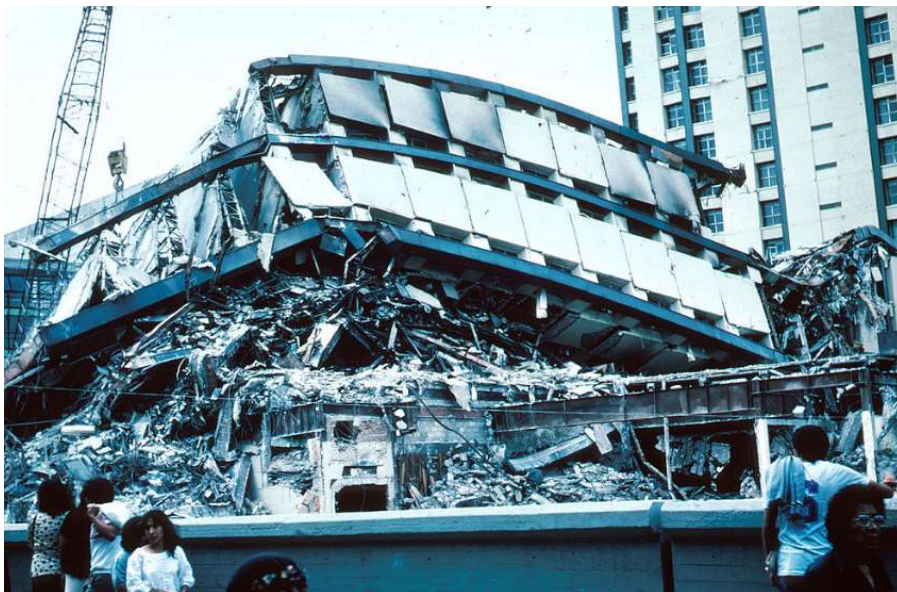
Figura 7.2. Una de las torres colapsada del Conjunto Suarez. Fuente: Google Imágenes.
