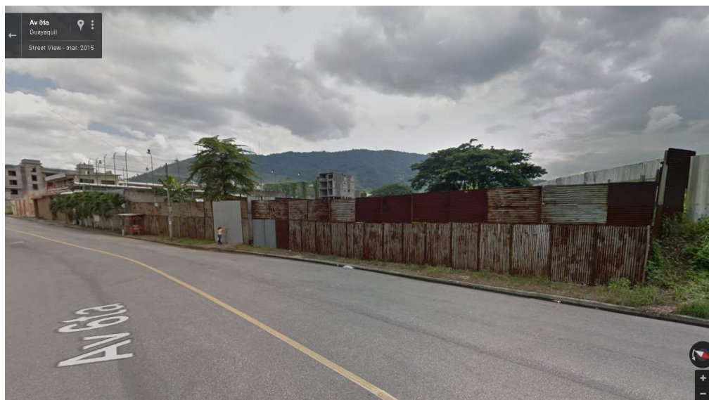
Figura 2.8. Vista frontal del lugar de la obra. Fuente: Google Earth, 2016.
