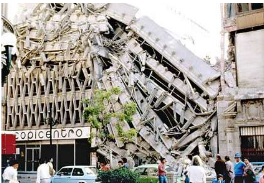
Figura 7.3. Edificación colapsada. Fuente: Google Imágenes. (Vega, 1996)
