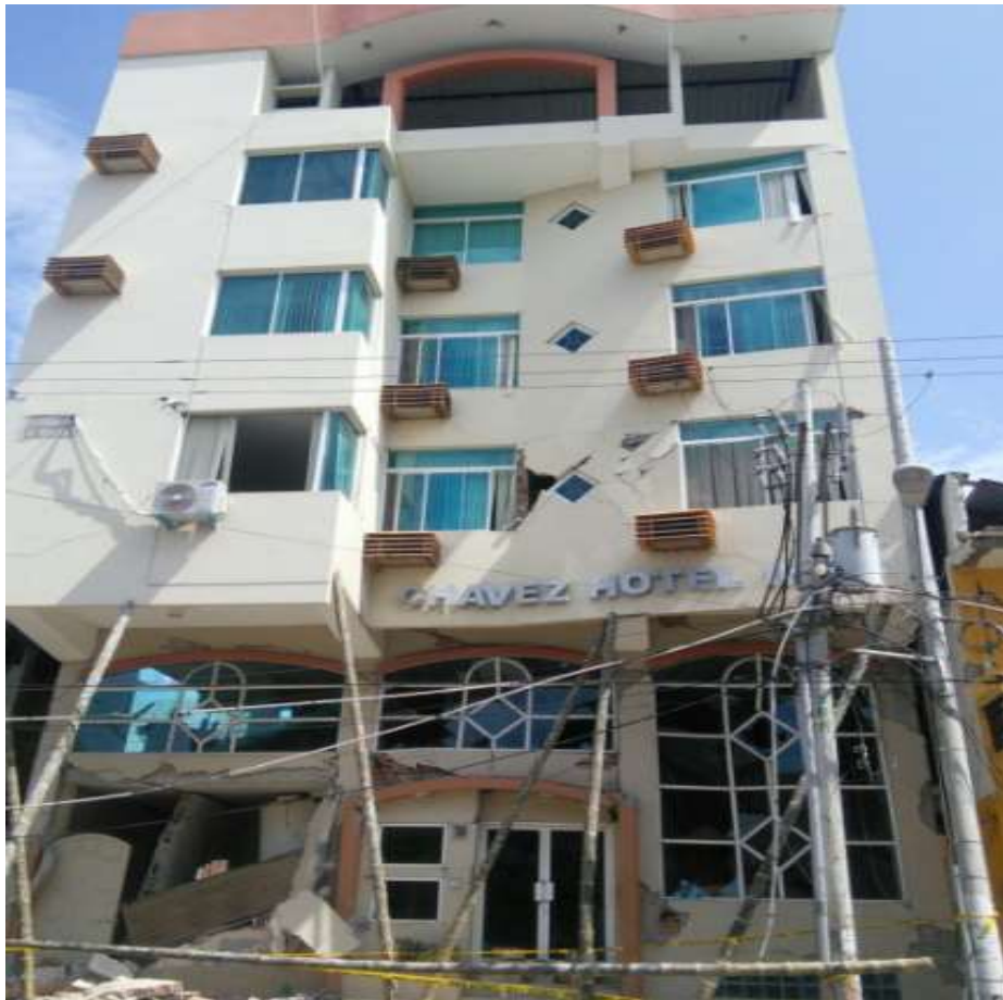
Figura 3.5. Hotel Chávez, cambio de rigidez vertical, sismo de Pedernales 2016. Fuente: Autores, 2016.
