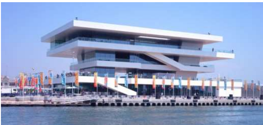
Figura 3.3. Edificio Foredeck en Valencia. Fuente: Arq.mx.com, 2015.
