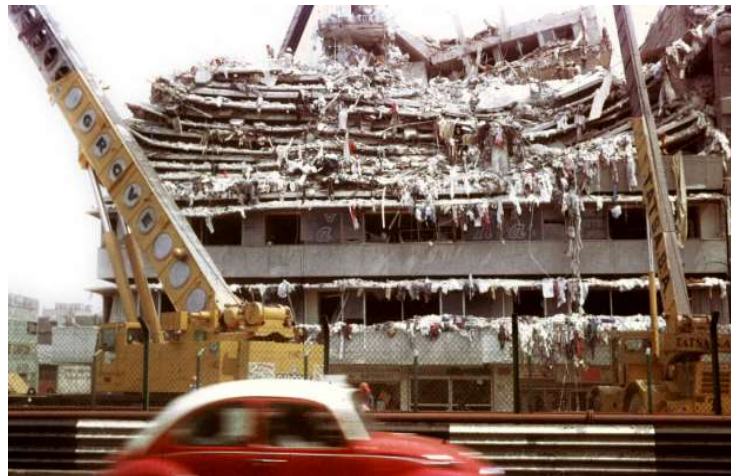
Figura 7.1. Edificio de costureras colapsado. Fuente: Google Imágenes.
