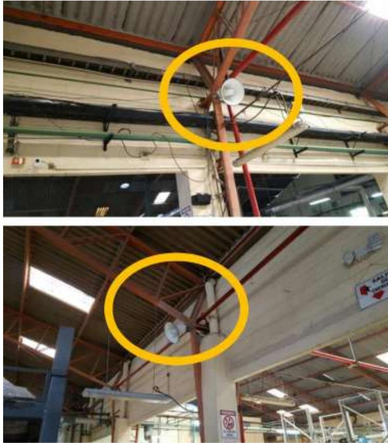
**Figura 2.20 Megáfonos Instalados en la Planta**
