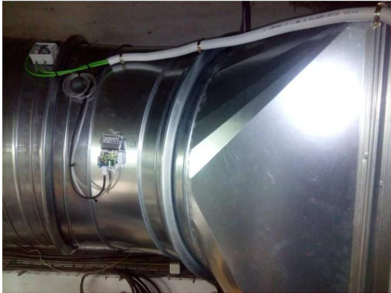
**Foto 3.5.** Detalle sondas de presión diferencial.
