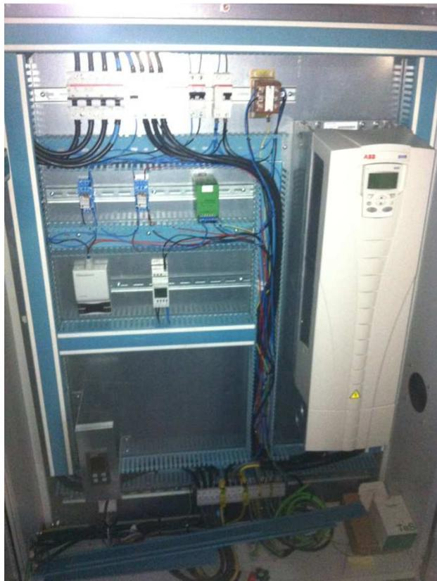
**Foto 3.8.** Cuadro eléctrico Generador de aire caliente.
