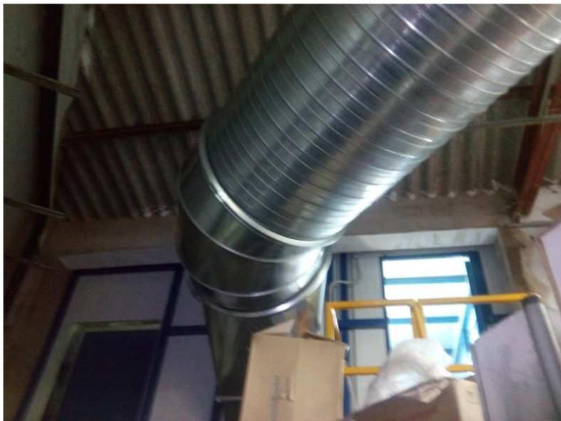
**Foto 3.6.** Tolva de conexión a Generador de Aire Caliente.
