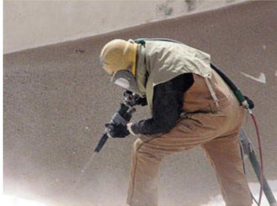
**Figura 1.2. Limpieza por sandblasting portátil**
