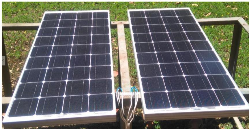
**Figura 4.3 Paneles fotovoltaicos conectados en paralelo.**
