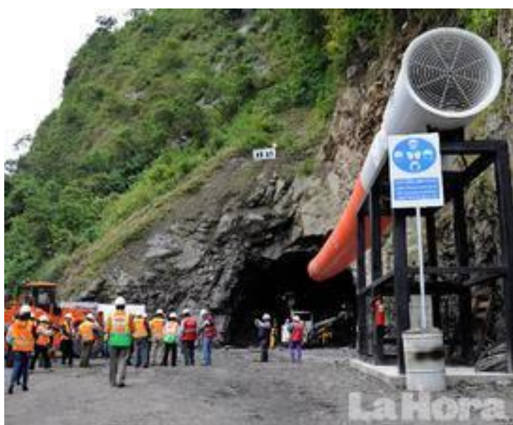
Figura 3.5: Túnel vial en Santo Domingo-Ecuador [37]
