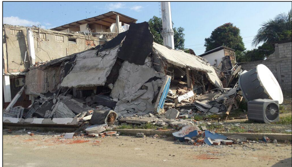
Figura 1.9: Infraestructura y torre de telecomunicaciones destruida, central telefónica CNT-Jama
