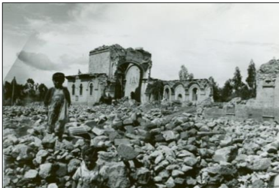
Figura 1.1: Escombros del terremoto ocasionado en Ambato [1]
