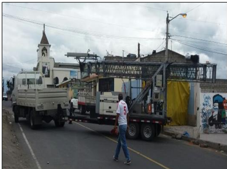
Figura 1.14: COW reubicada e instalada en Jama-Manabí
