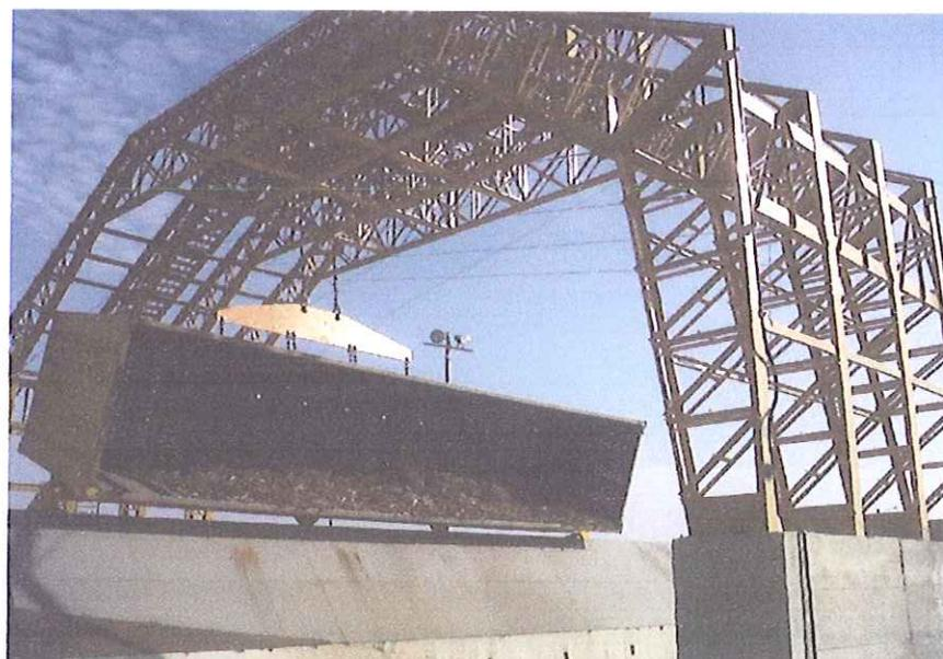
**FIGURA 1.4 IZAJE DEL VAGÓN CON CILINDROS Y
