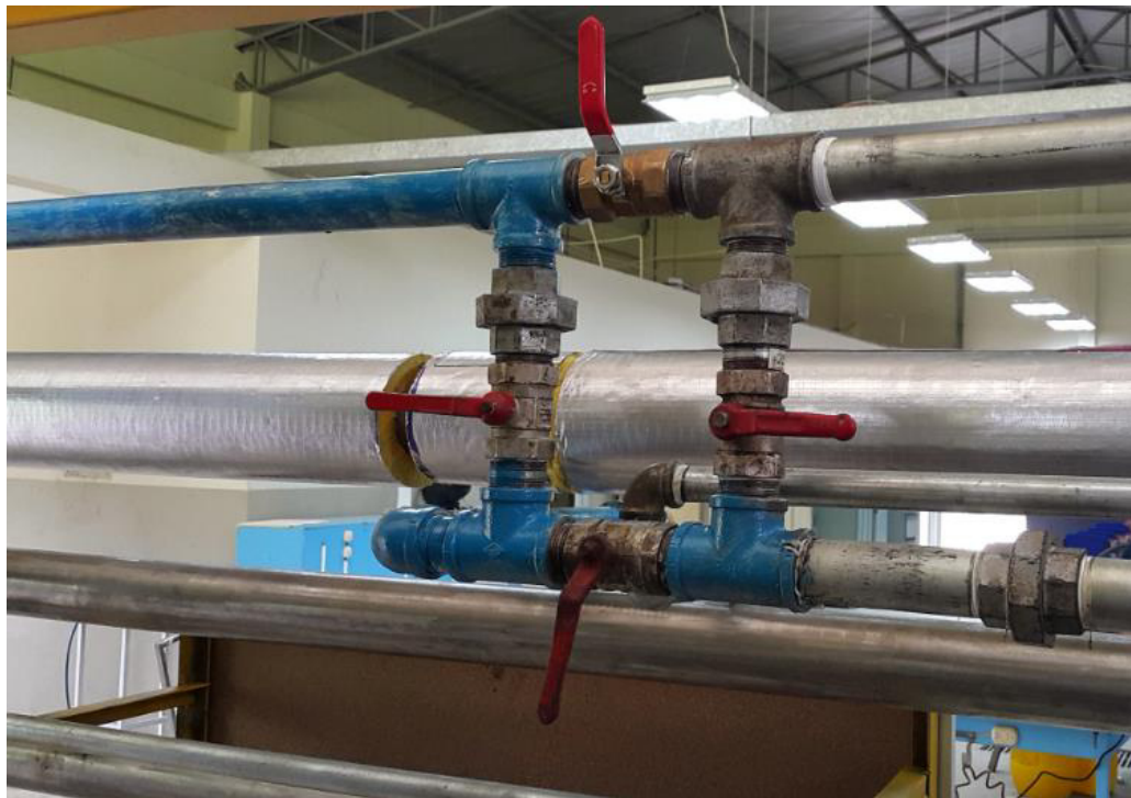
Gráfico 11. Instalación de líneas de alimentación y accesorios.
