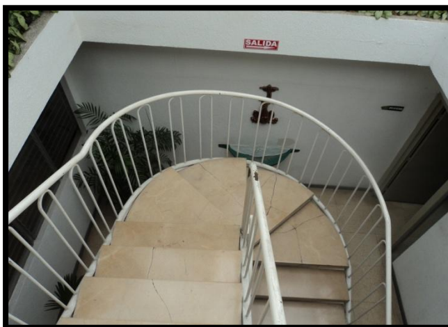
Fig. 2.32 Escaleras de caracol
