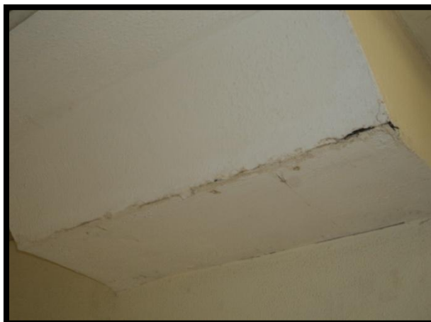
Fig. 2.26 Ductos de aire acondicionado.
