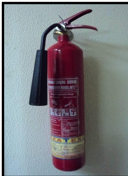
Fig. 2.20 Extintor de Gas Carbónico con capacidad 10 lbs.
