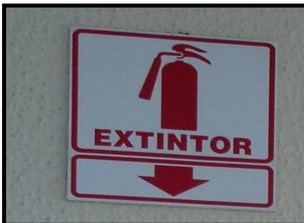
Fig. 2.5 Señales de Extintor
