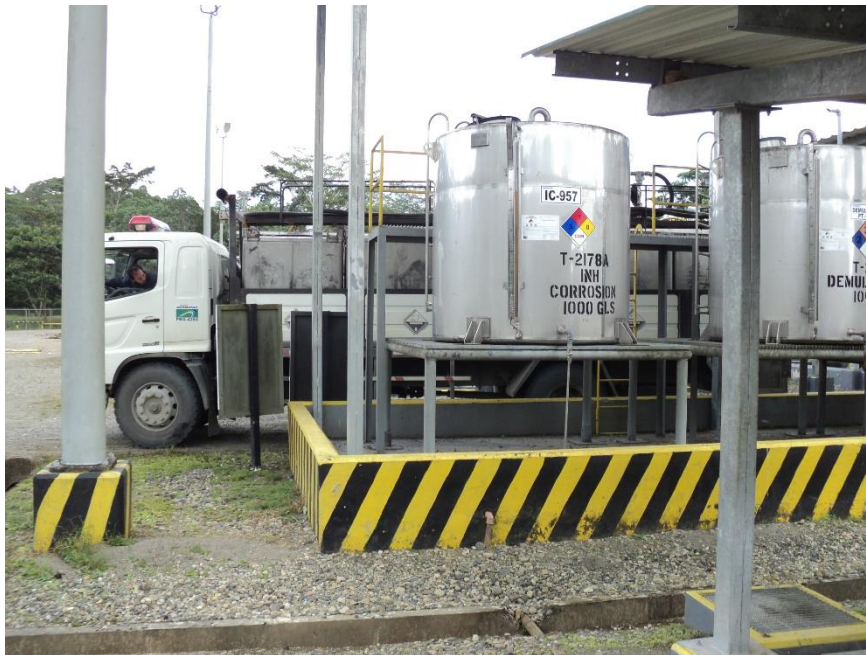
Ilustración 6 Tanqueo de inhibidor de corrosión
