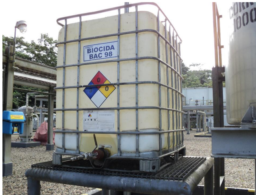
Ilustración 5 Inyección de Biocida en campo
