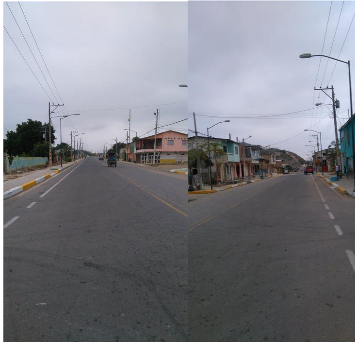
Figura 4-0-1 Vía principal de Acceso a Crucita
