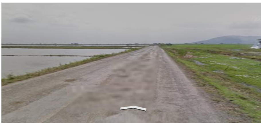
Figura 2.3 Vía de acceso a la Columna Fuente: Celleri, C., Peñafiel, A., 2016.
