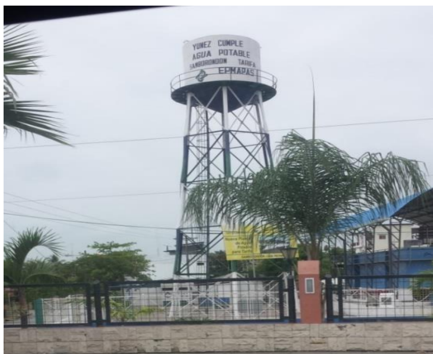
Figura 3.8 Tanque Elevado Fuente: Celleri, C., Peñafiel, A., 2016.
