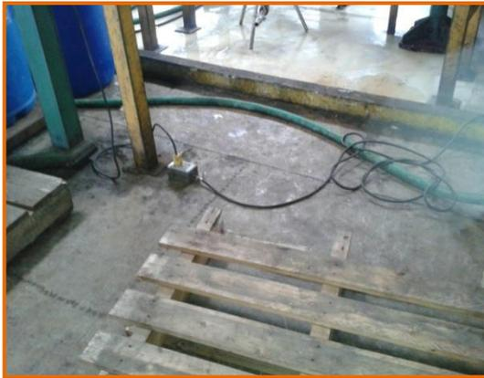
**Figura 4.3 Cables Sin Protección**
