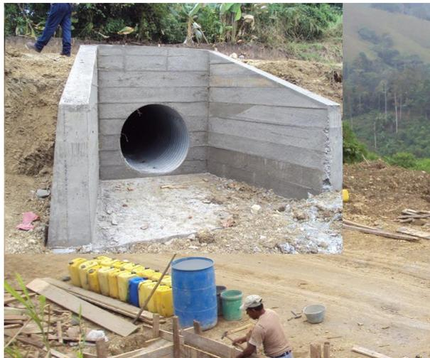
**Figura 4.3** Elementos de descarga Muros de ala.
