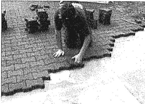
Fig. 2.14 Pavimentos de seguridad usando NFU
