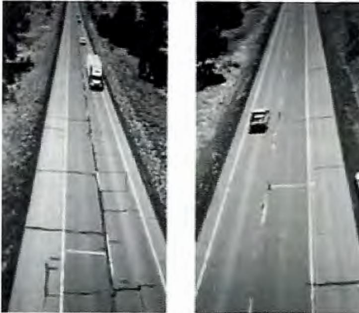
**Figura 3. 1.** Fotos de dos tramos de carretera con asfalto convencional y asfalto-caucho. [13]
