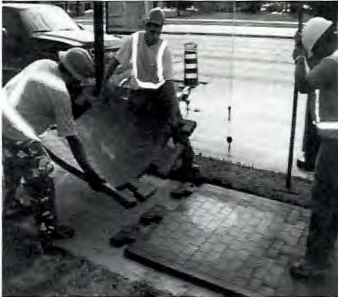
Figura 3. 4. Colocación de Suelos de seguridad. [44]
