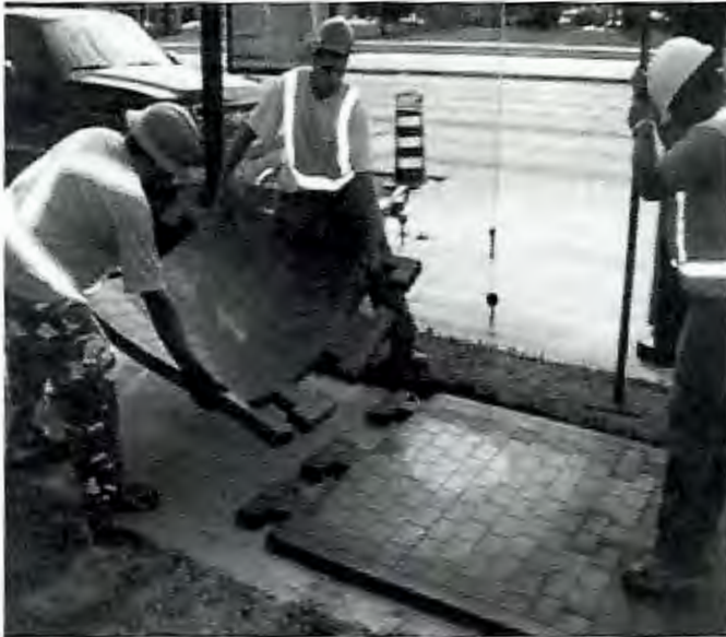
Figura 3. 4. Colocación de Suelos de seguridad. [44]
