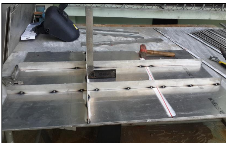
Figura 22: Soldadura de los refuerzos a los segmentos de plancha.
