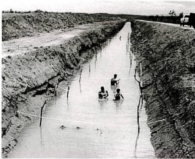
Figura 8. Canal de drenaje
