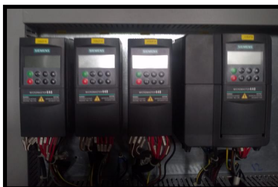
Figura 4.5: Variadores Micromaster 440 modo OFF [18]
