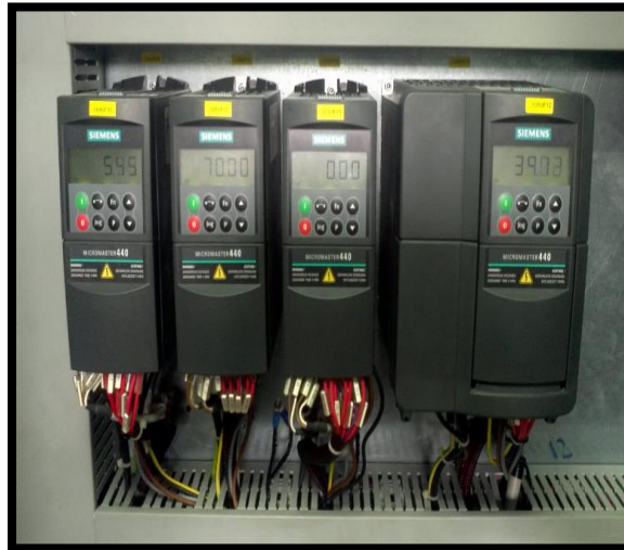
Figura 4.6: Variadores Micromaster 440 modo ON [18]
