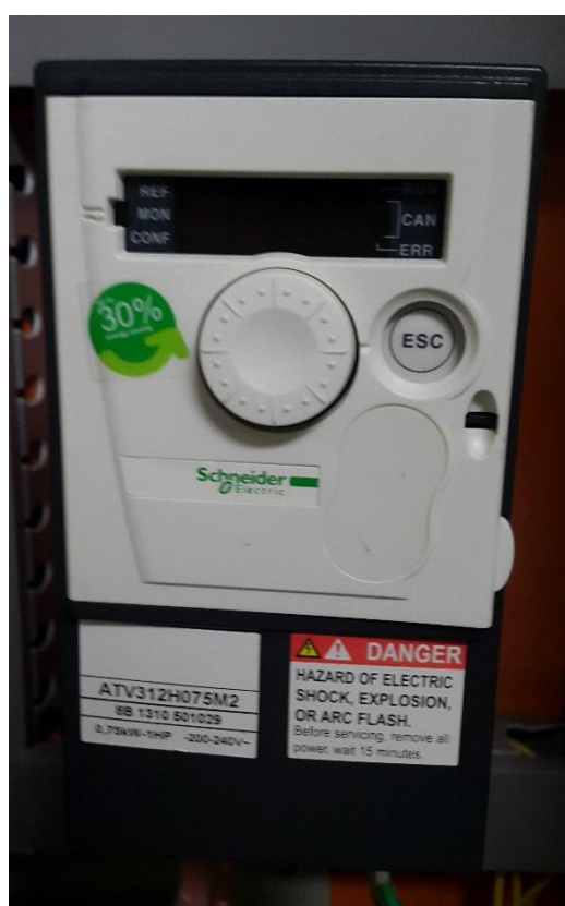
Figura 2.3 Variador de frecuencia
