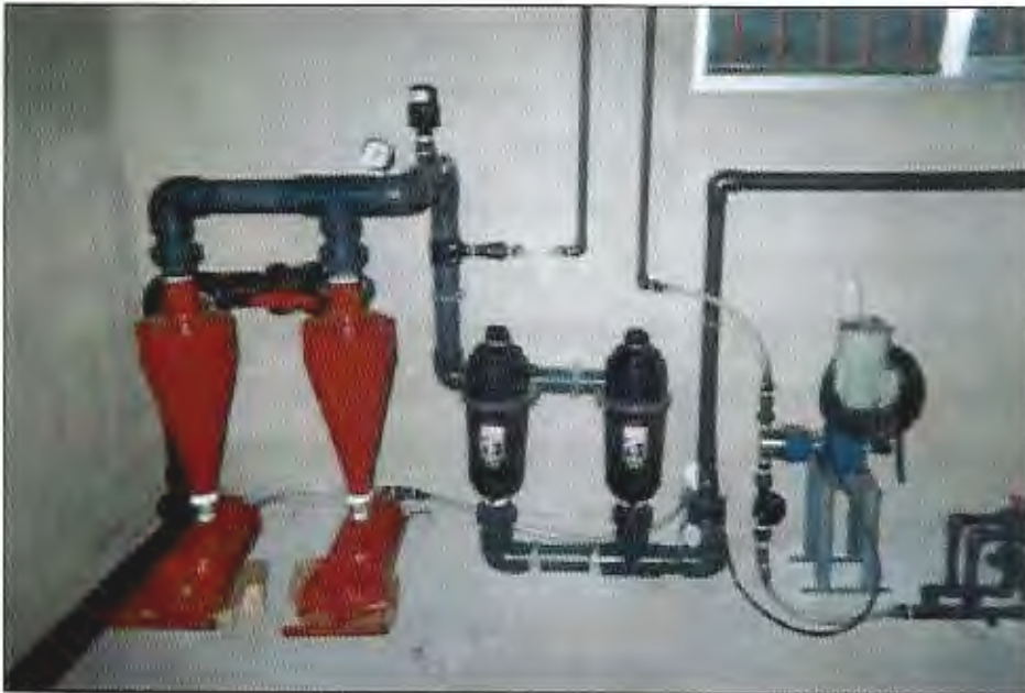
Figura 4. Cabezal de filtrado. Fuente: www.raulpalomo.com
