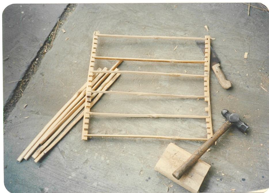
FIG. 34.- ARMADO DE LA ESTRUCTURA DE CAÑA
