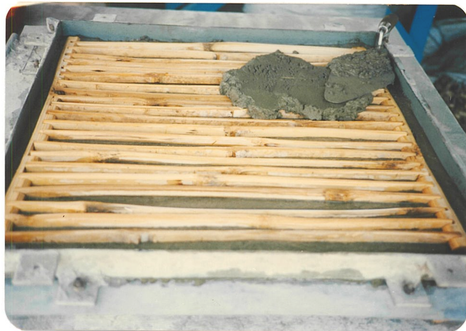
FIG. 38.- LLENADO CON MORTERO
