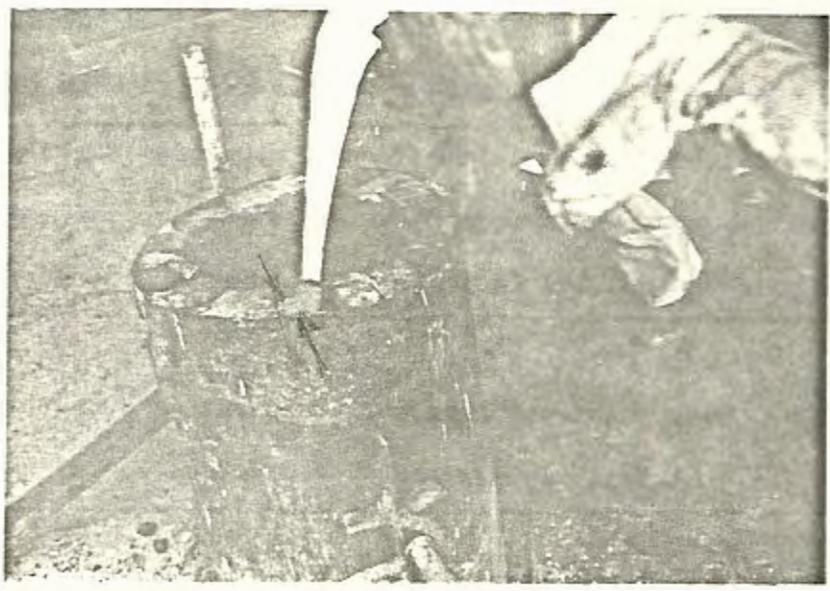
Figura 33. Colocación del arrabio en el convertidor
