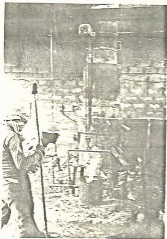
Figura 27. Cubilote de 50 cm de diâmetro interior.
