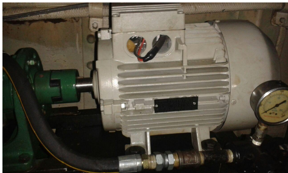
Figura 4. 7: Servomotor instalado del B.A.E "Chimborazo"
