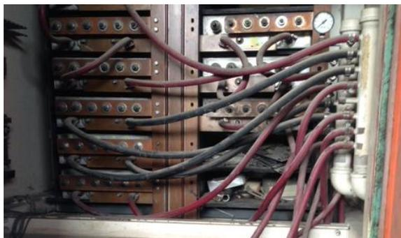
**FIGURA 1.3** Banco de capacitores del horno
